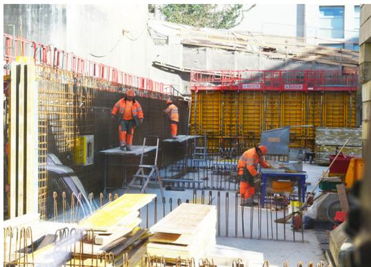
1. Le coffrage, qui constitue l'enveloppe provisoire qui doit recevoir l'élément bétonné;
